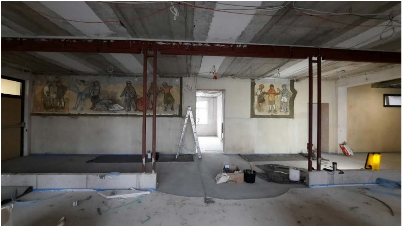
Abb. 19 Umgebaute Wandsituation, anstelle der Stahlkonstruktion wurden später großformatige Gläser eingesetzt, so dass man vom Ruheraum aus die gesamte Malerei betrachten kann und auch eine natürliche Lichtquelle im Flurbereich vorhanden ist.
