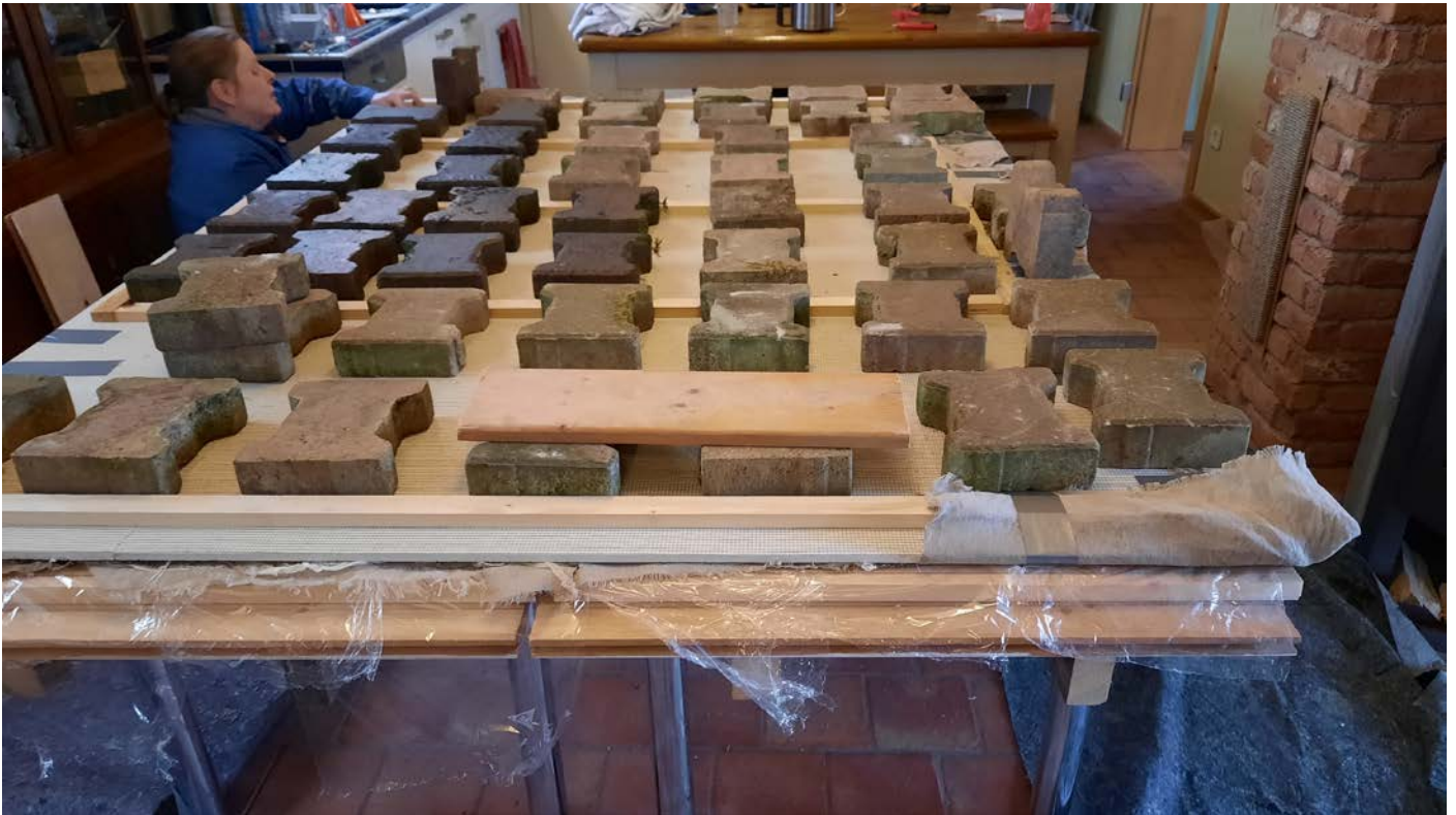
Abb. 15 Ausdünnen des abgenommenen Putzes auf 2 mm.
