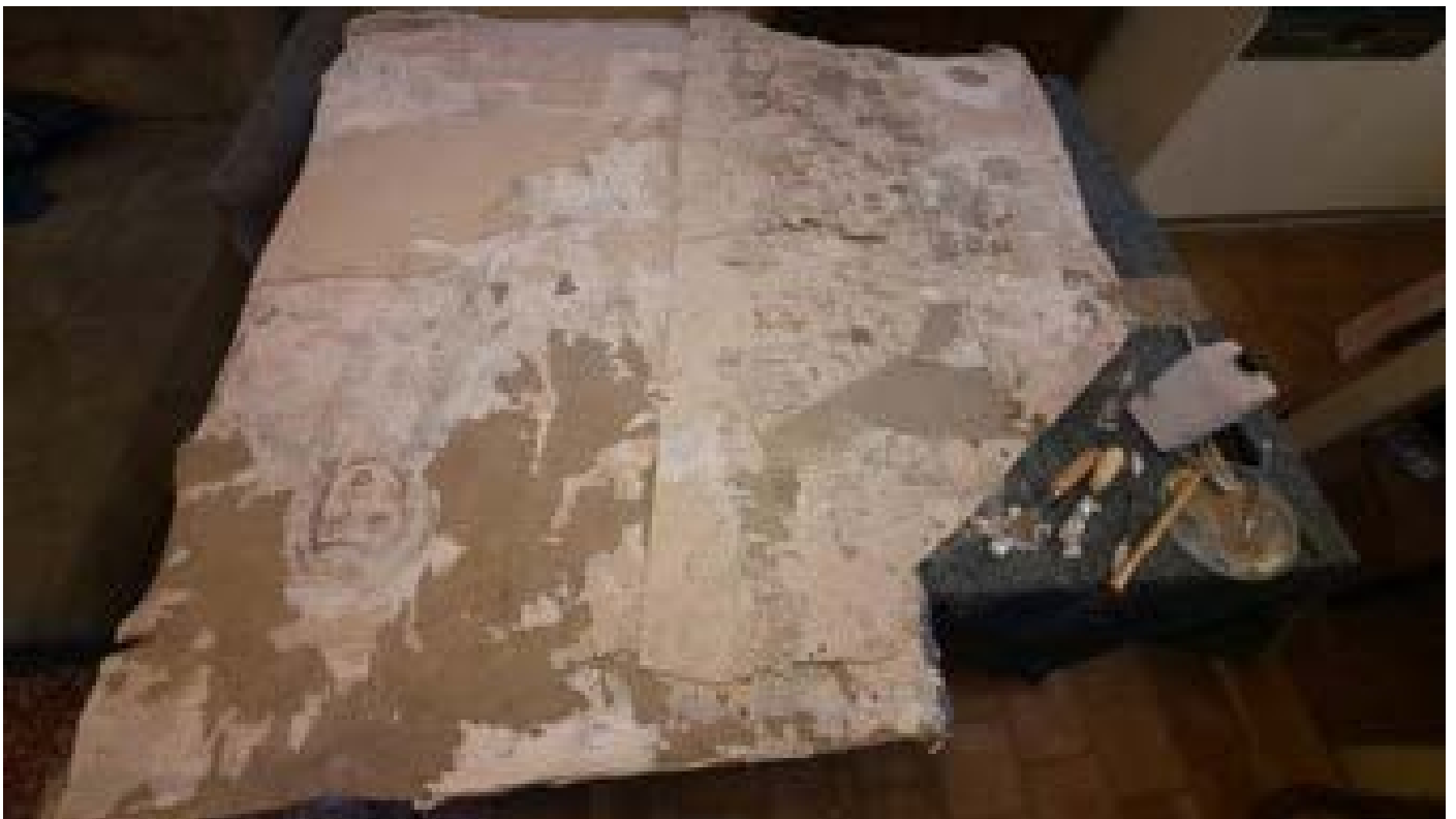
Abb. 14 Ausdünnen des abgenommenen Putzes auf 2 mm.
